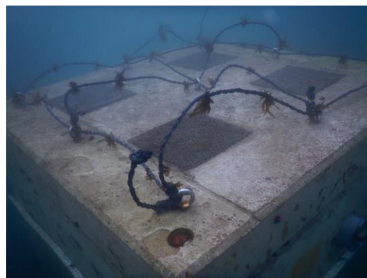
写真-3 ブロックの設置状況（岩手）
