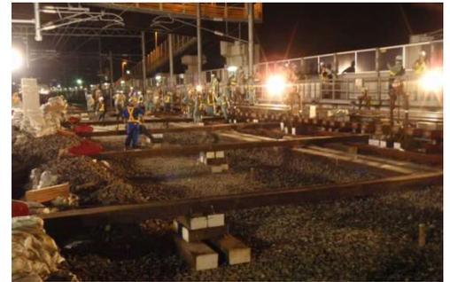
図-2 長マクラギによる横移動用架台
