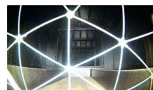
図-10 ドローンから見た箱桁内部 (1)
