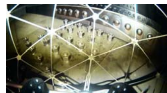
図-11 ドローンから見た箱桁内部 (2)
