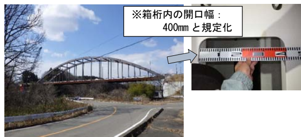
図-4 箱桁内の点検
