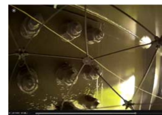
図-13 点検不能区間
