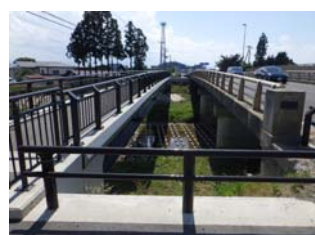
図-12 離隔のある側道橋
