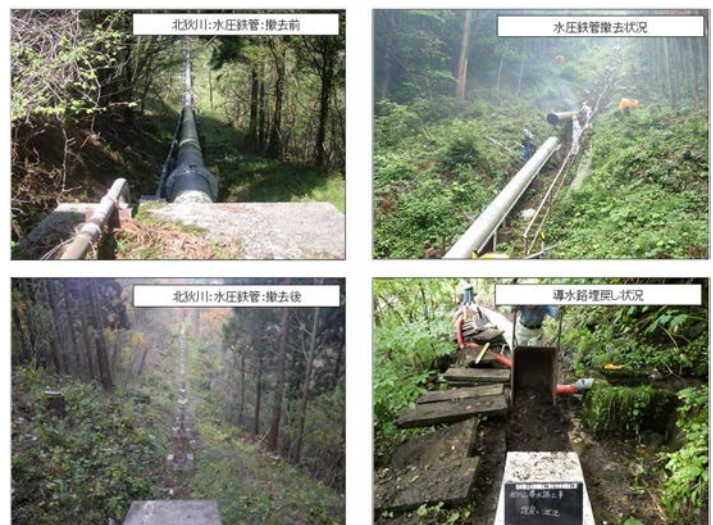
写真二 撤去状況
