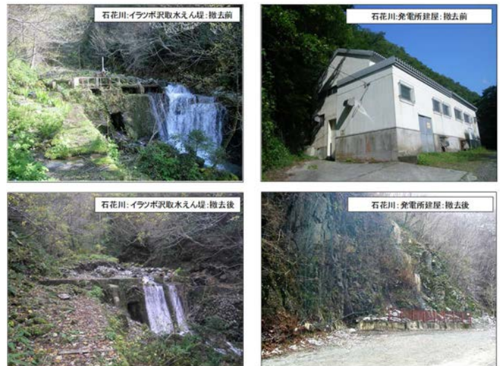
写真一 撤去状況
