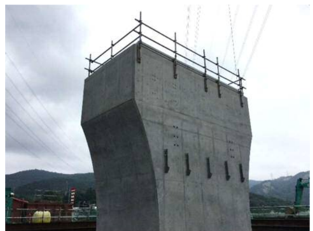
写真1 P1 橋脚躯体完了
