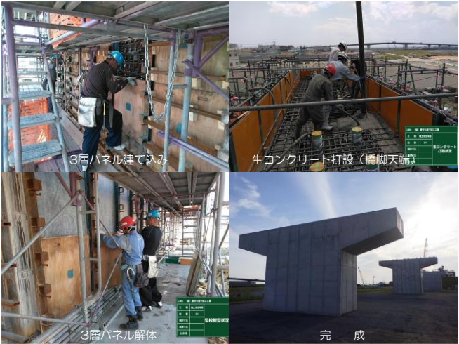
写真- 1 「CF 工法」施工状況
