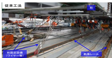
図-5 従来工法の桁固定状況例
