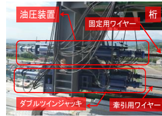
図-6 新工法の桁固定状況
