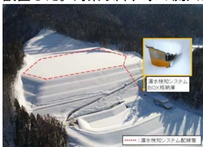
写真：漏水検知システムの配管位置
