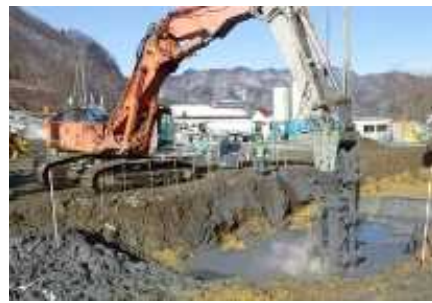
写真：パワーブレンダー工法での鉾津改良状況
