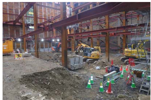
写真－1 工事状況
