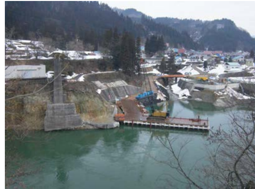
写真－４ 仮設構台設置完了状況
