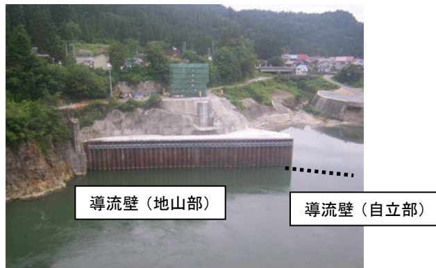
写真－2 施工後（上流より下流を望む）
