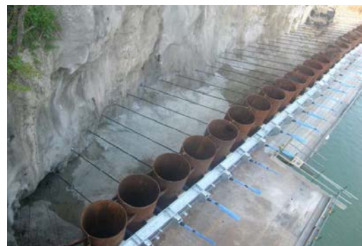
写真－６ PCアンカー設置状況
