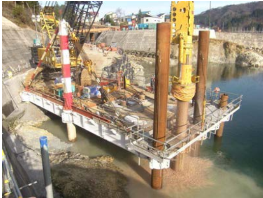
写真－３ 仮設構台設置状況
