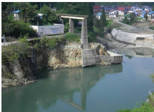
写真－1 施工前（上流より下流を望む）
