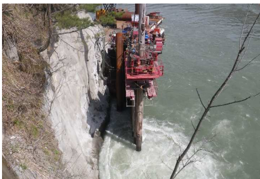
写真－５ 地山部 鋼管矢板削孔状況
