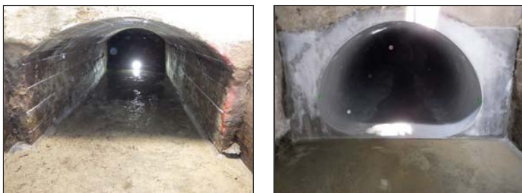
写真-1 着手前および完成写真
