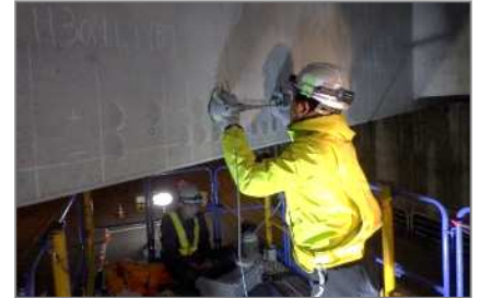
写真-2；グラウト充填調査状況
