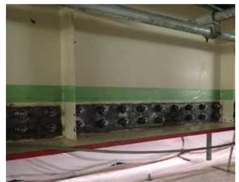
写真-1 下フランジ側補強状況
