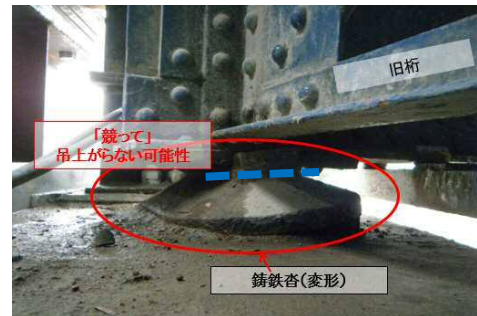
図-8 既設沓座部
