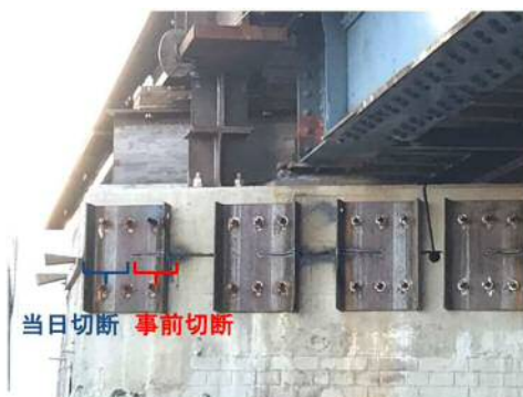
図-7 旧橋台切断部
