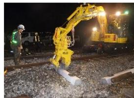
写真-7 マクラギ挿入
