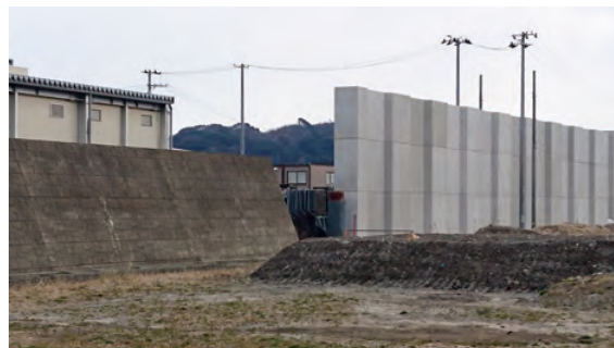
図-1 被災前(左)と新設(右)の防潮堤
