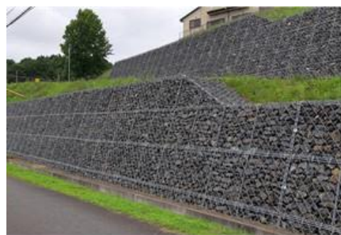
写真-2 ふとん籠擁壁(2019)
