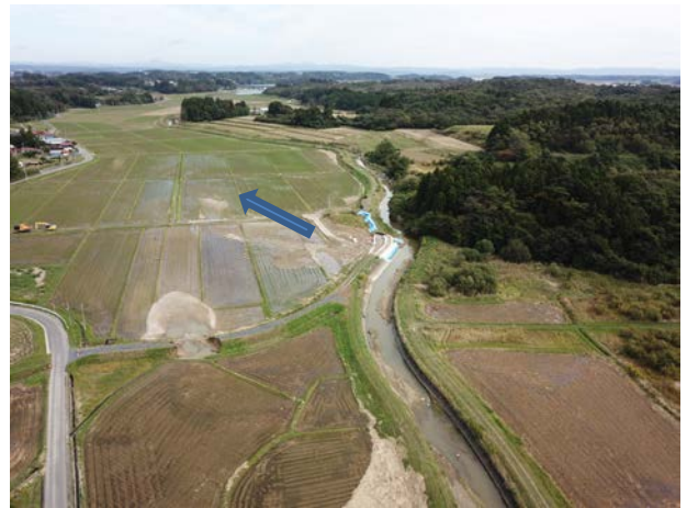
図 4 照越川破堤地点
