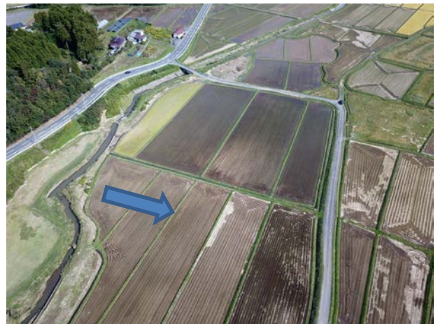
図 5 瀬峰川破堤地点
