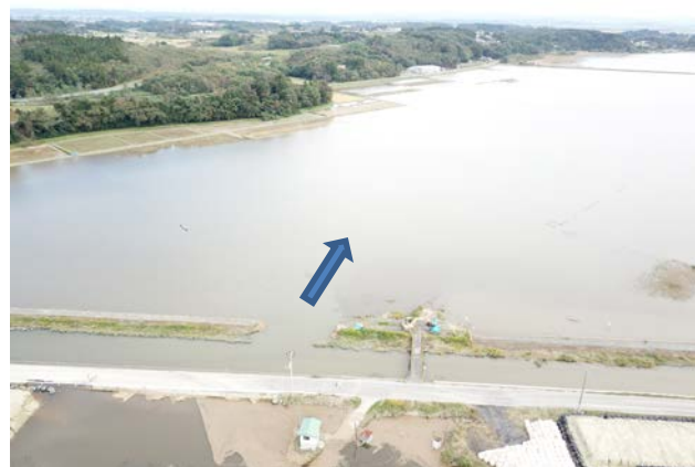
図 2 荒川破堤箇所
