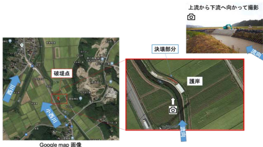
図 2 小西川決壊地点の様子(左: 西川合流点と決壊地点の位置関係, 赤枠: 護岸と決壊地点の位置関係, 右上: 決壊地点の様子)。
