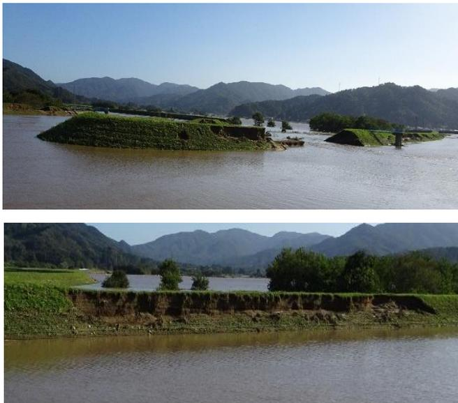
図-1 新川における破堤(上)部分的な法面侵食(下)
