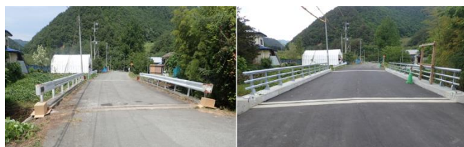
写真-2 全景写真(床版取替前後)
