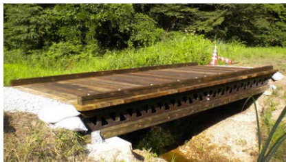
図-1 プレストレス木箱桁橋
