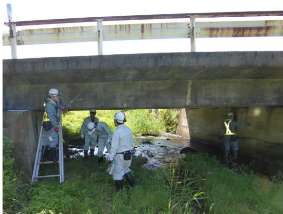
(a) 点検前の様子
