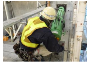
図-3 PC 縦締め緊張状況（ウェブケーブル）
