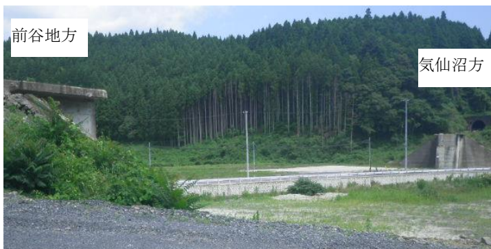
写真-1 震災直後の当該橋りょう
