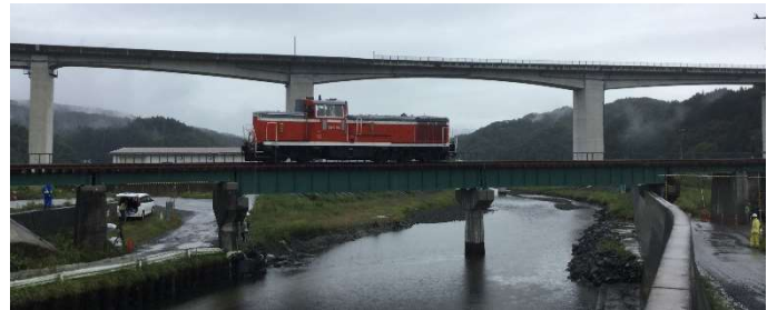
図-3 第一織笠川橋りょう桁たわみ試験
