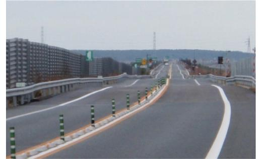
写真-1 軟弱地盤上における不同沈下の例
