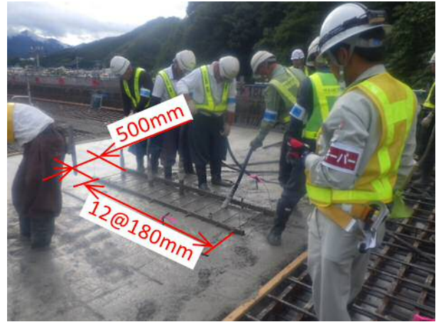
写真-1 バイブレーターの挿入位置確認
