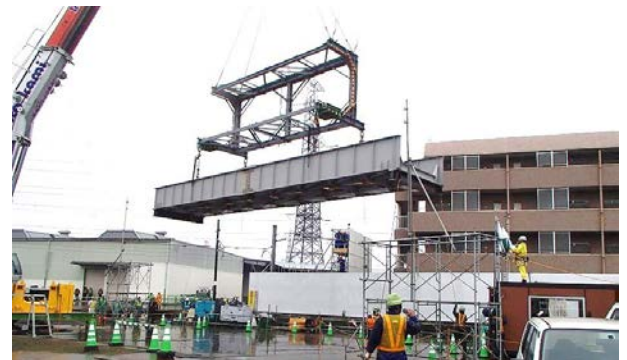
写真-3 試験吊り状況
