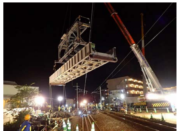
写真-4 工事桁架設状況
