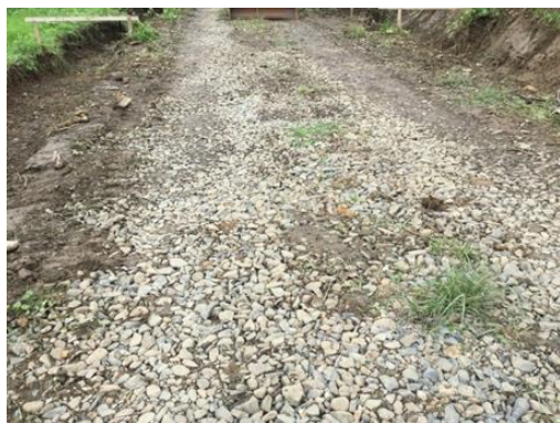
写真-1. 鉄道路盤と混ざり合ったバラスト
