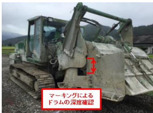
写真-2. スタビライザーによる攪拌の施工管理
