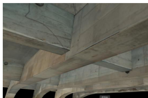
図 1 MR 橋梁点検支援システムの様子
