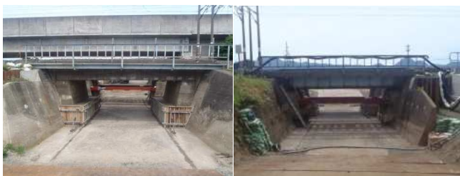
図-2 下り線旧橋りょう 図-3 上り線旧橋りょう
