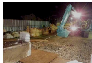
図-10 RC 桁引抜
