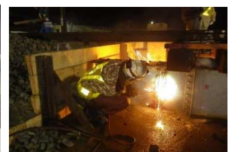
図-11 鋼桁ガス切断
