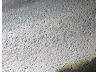
写真-4 上川原幹線用水路
