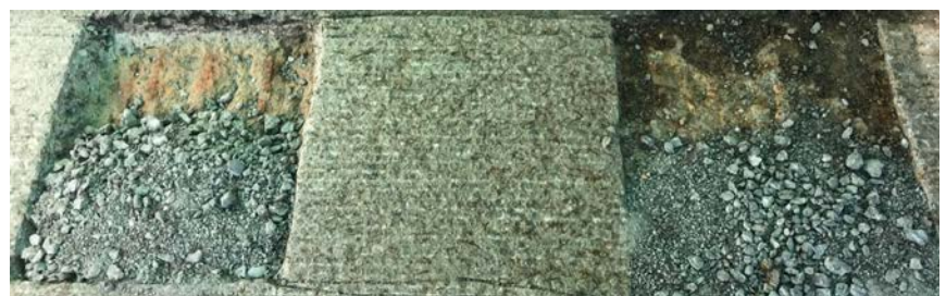
砂利を詰めた状況
