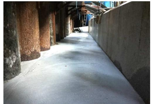
写真-1 流動化処理土充填状況
