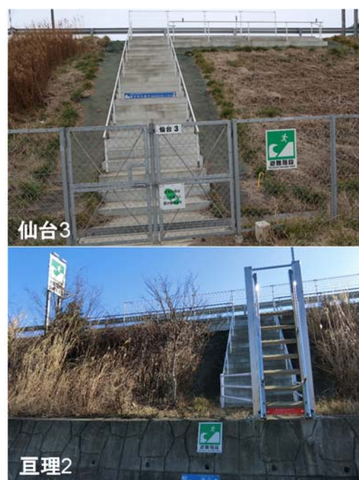
図 1 高速道路の津波避難階段 （仙台 3（フェンス型）と 亶理 2（はしご型）の設置例）
