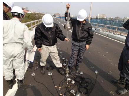
図-3 小型 FWD 試験計測状況
