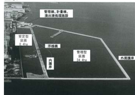
図 3.2 公益財団法人愛知県臨海環境整備センター（アセック）衣浦港 3 号地廃棄物最終処分場事業全景(面積 47.2ha、容積 496 万 m 3 )（公益財団法人愛知県臨海環境整備センター資料参照）
