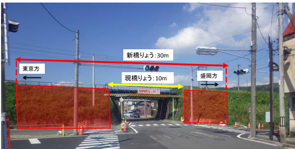
図-1 現場写真（上り線側）
