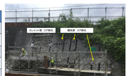
図-7 コア抜き施工
