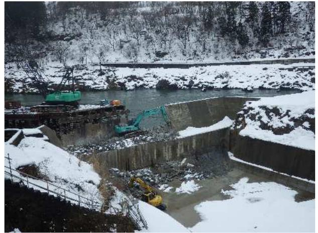
写真-2 仮締切擁壁解体施工状況
