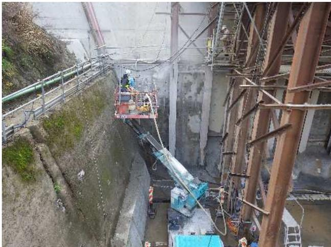
写真-1 先行削孔施工状況
