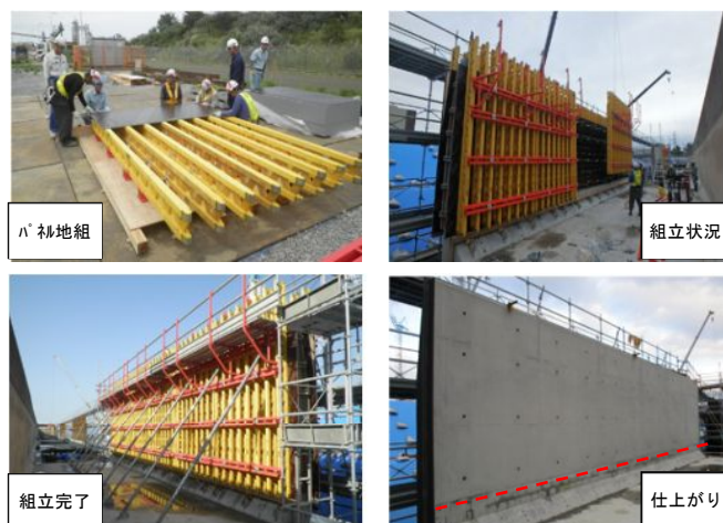
写真1 施工状況写真
