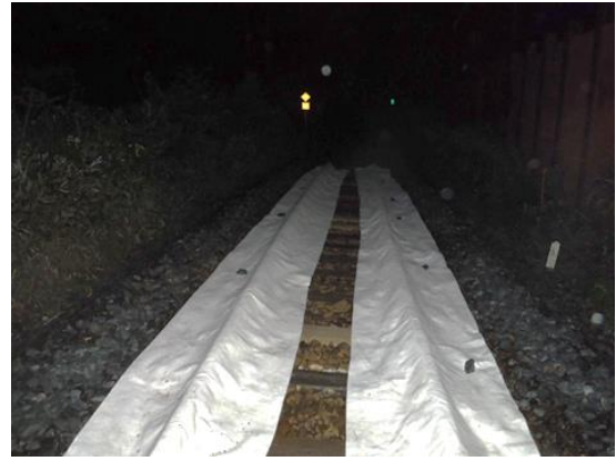
図-5 養生マット 敷設状況
