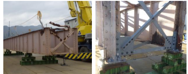
写真-2 鋼桁補修前（左）及び補修後（右）
