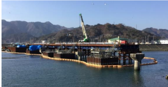
写真-1 シートパイル基礎による橋脚復旧状況
