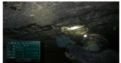
写真4 浮き部の斫り状況
