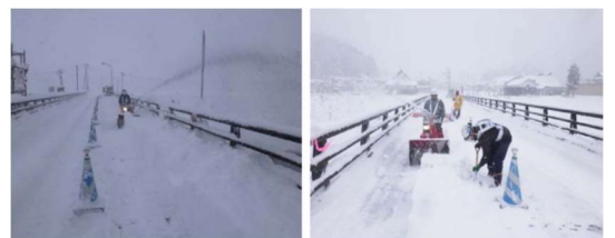
写真6 規制帯内の除雪作業状況
