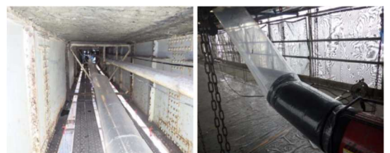
写真5 ジェットファーンズ養生状況
