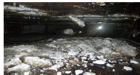
写真 2 鋼板を剥がした状況
