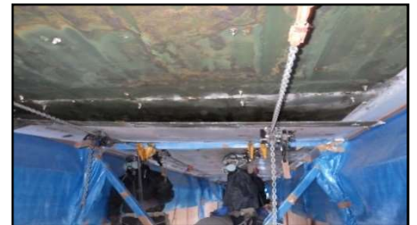
写真3 鋼板撤去の落下防止対策
