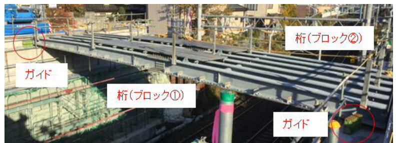
写真-1 ブロック①ガイド設置
