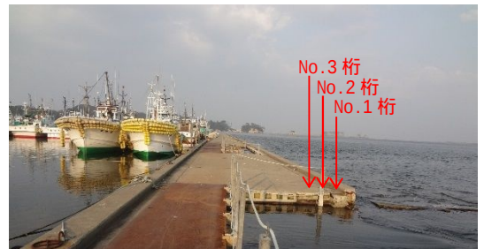
写真-1 架橋状況
