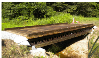
図-1 プレストレス木箱桁橋
