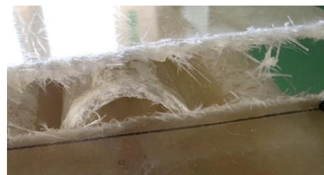
写真-1 破壊状況
