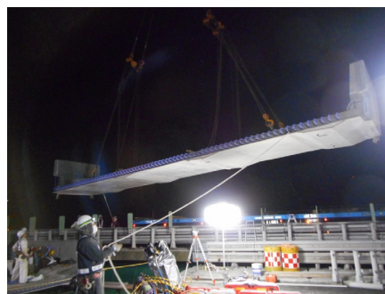
写真2 プレキャスト床版の架設
