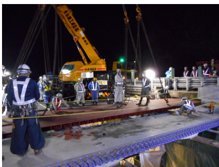
写真1 仮設鋼床版の設置
