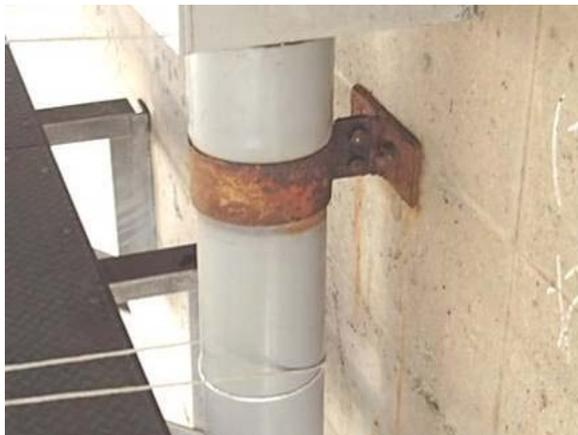
写真-1 一般普及の排水管取付け金具
